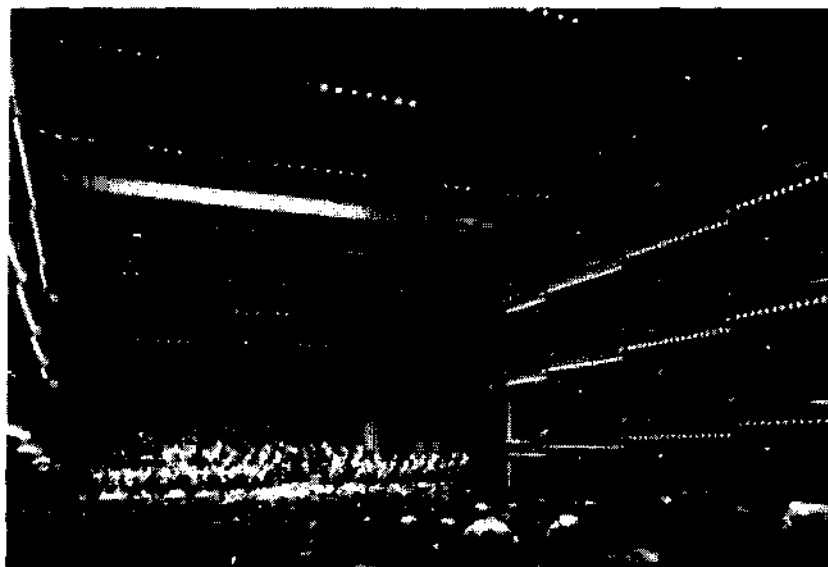
Fig. 3 Avery Fisher Hall. Note as irregularidades no teto, que refletem as ondas sonoras em todas as direções; assim, elas fornecem uma excelente superfície de difusão das ondas sonoras. A difusão do som equaliza a sua intensidade por toda a sala de concertos e elimina pontos mortos, focos e ecos problemáticos.
