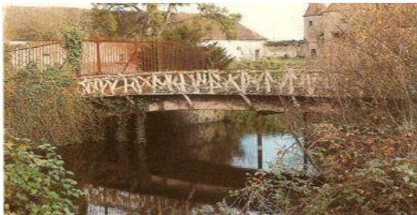
Figura 1 - A ponte de Mounier, os detalhes do guarda-corpo imitam galhos de árvore.
