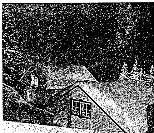
Foto 5.3 Os telhados das construções mostradas devem ter capacidade de suportar não apenas o peso total da neve, mas também as cargas distribuídas assimétricas resultantes da camada depositada de neve.
