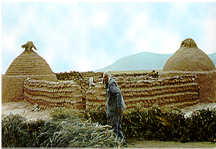
Vivienda rural de tierra con dos habitaciones Altiplano de La Paz (Foto: A. Calla)
