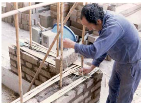
Fig. 15 – Construcción e instrumentación de módulo de adobe con refuerzo de caña.
