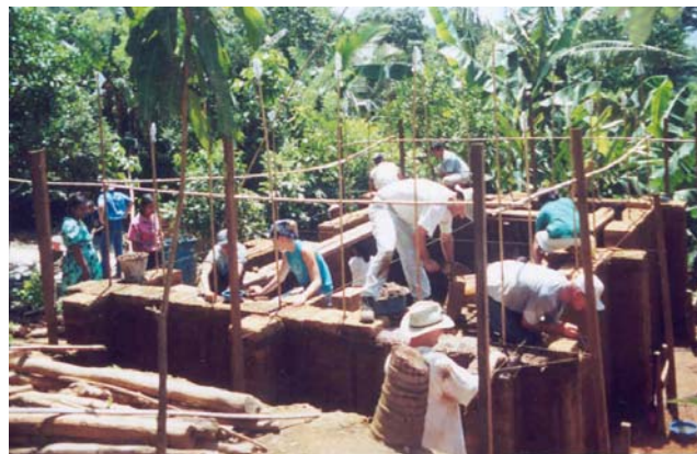
Figura 3: Proceso de construcción vivienda modelo.
