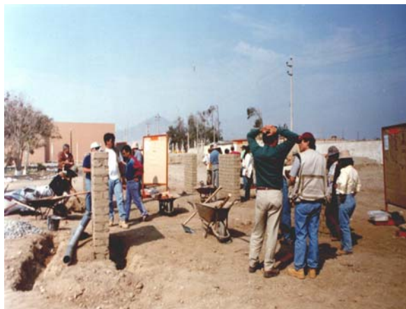
Fig.8 – Execução de drenagem – Curso PAT99/Peru
