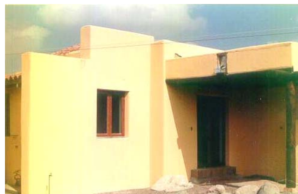
FOTO 8. Vista parcial del corredor del comedor y dormitorio de servicio.
