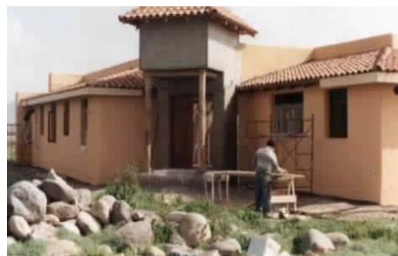
FOTO 6 Vista torreón de acceso desde surponiente.
