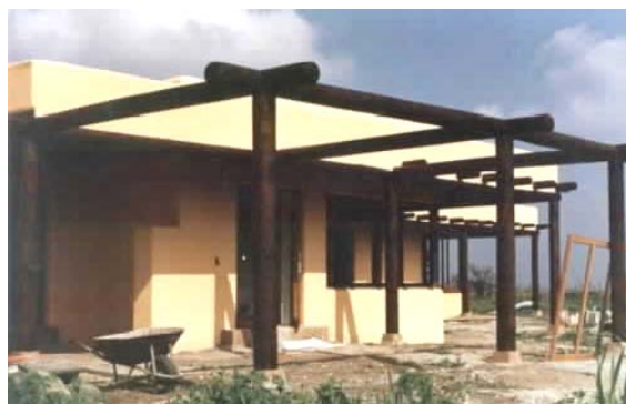
FOTO 5 Vista corredor fachada norte.
