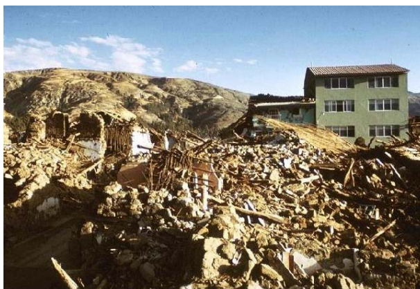
Fig. 1 – Colapso total de viviendas de tierra.
