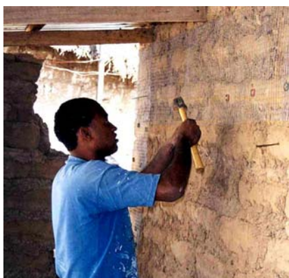
Fig. 17a – Refuerzo de malla de alambre electrosoldada.
