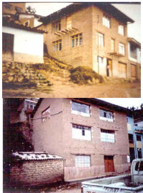
Fig. 9 – Viviendas de adobe de tres pisos.
