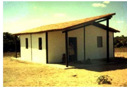
Figura 06. Colocação dos painéis, fixados em pilares e maçaranduba em construções localizadas em João Câmara, Rio Grande do Norte, Brasil. (Foto: Guadêcio Torquato)
