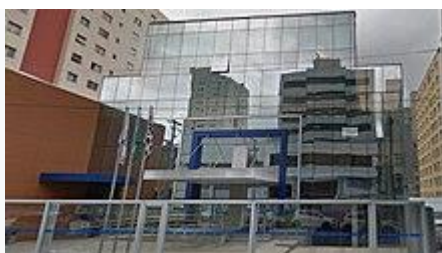
Fachada do prédio da ABNT.
