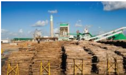
Figura 01: Pátio de estocagem de madeira
